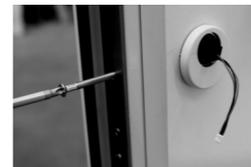
8 Bei Bedarf die Zylinderverlängerung (innen/außen) montieren und bündig mit dem Beschlag anzeichnen. Die Zylinderverlängerung verhindert ein Verspannen des Zylinders.
